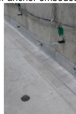
(d) Masonry support and telon sheet
